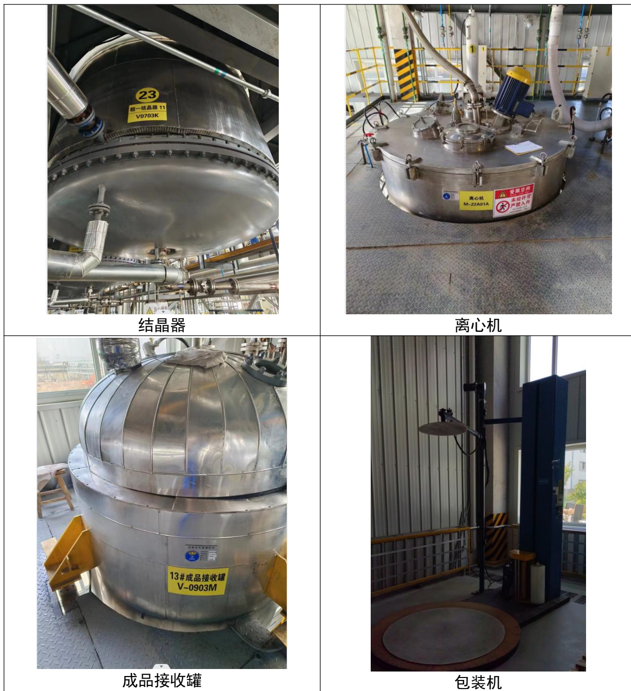
图 3. 2-3 本项目实际建设情况图
