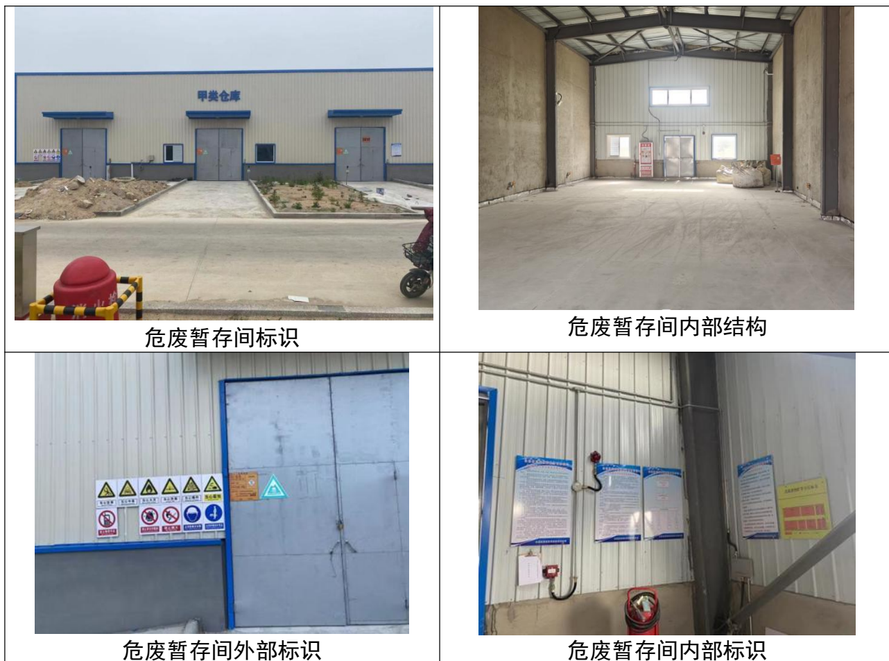
图 4.1-7 危废暂存间建设现状图
