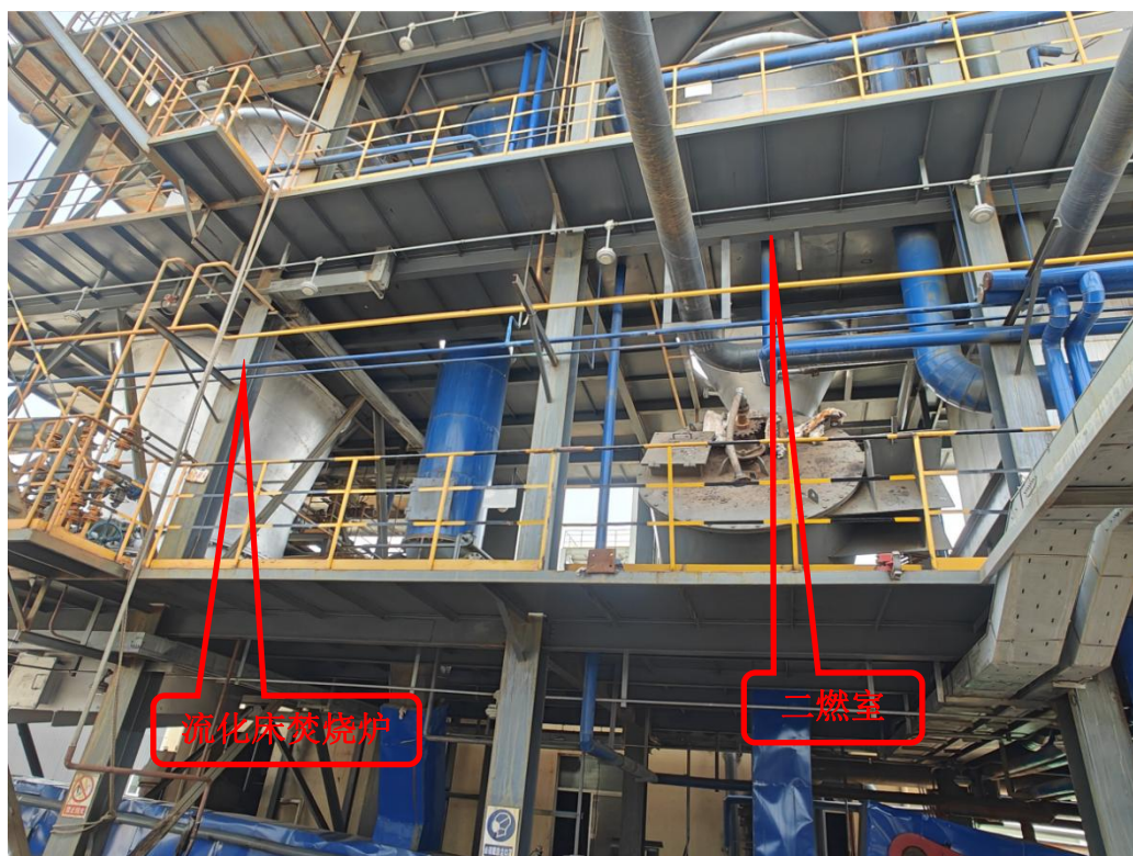
图 4.1-1 焚烧炉建设情况图
