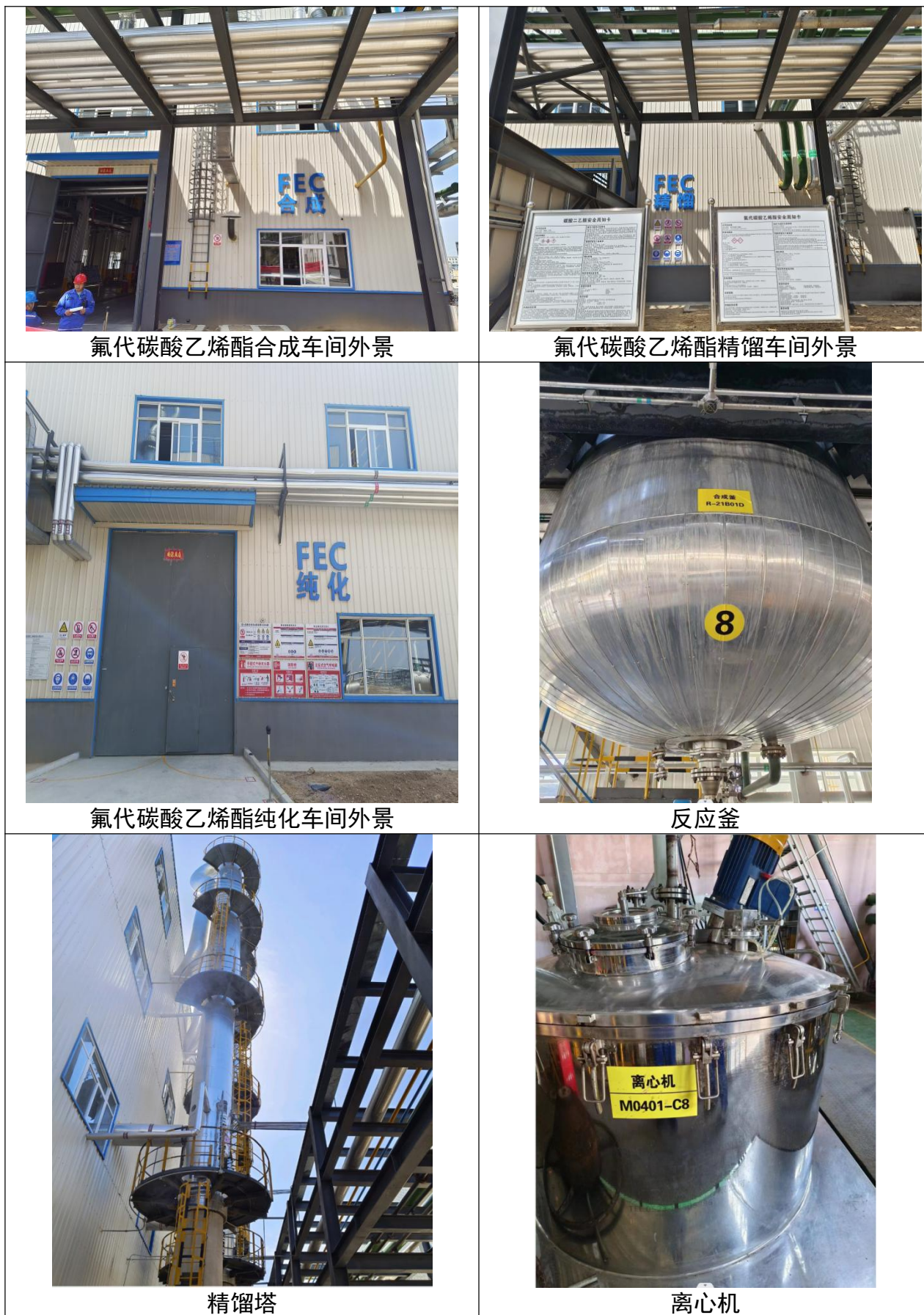
图 3.2-3 本项目实际建设情况图
